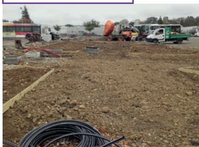
Ilôt central • circulation piétonne • bornes d'entretien bus Travaux en cours > livraison printemps 2019
