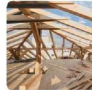
3. Structure maçonnerie, gros œuvre, charpente
